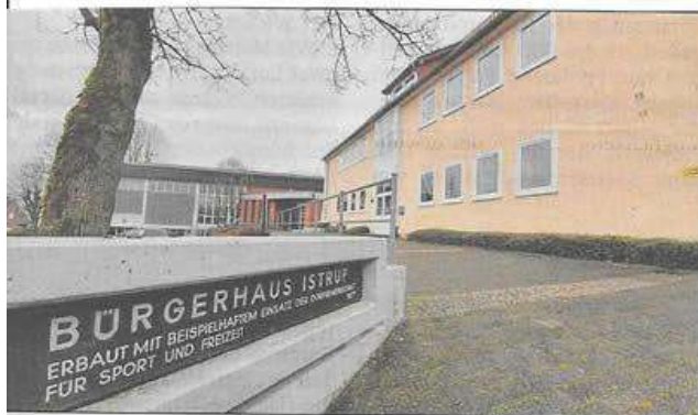
Durch die hohe Auslastung des Bürgerhauses in Istrup ist eine Erweiterung notwendig geworden. Foto: Dennis Pape
