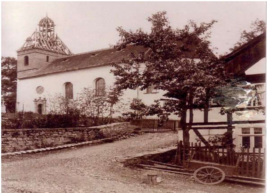
Fertigstellung des Turms 1904 Zugang Eisterholt/Flore
