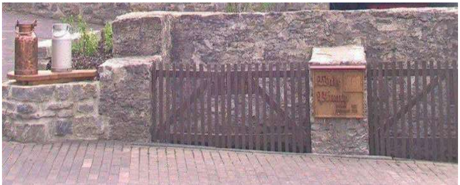
Nach der Renovierung 2002
