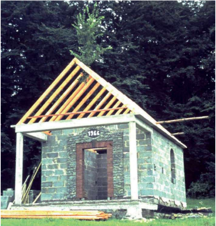
Rohbau der Heimkehrer-Kapelle und Fertigstellung 1966
