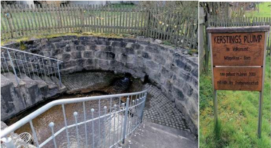
Nach dem Umbau 2008
