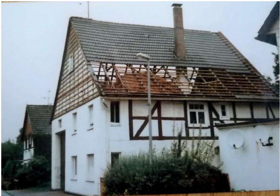
Das ursprüngliche Anwesen, ein Fachwerkhaus, ist von der Familie Albert und Anna Oeynhausen umgebaut worden; nach jahrelangem Leerstand wurde es abgerissen.
