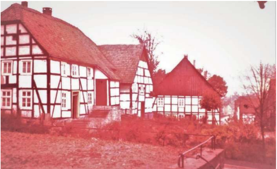
Lehrer- und Küsterhaus und alte Schule, Webershaus (Schule), Kaplanei, rechts Treppenaufgang zum Turmplatz
