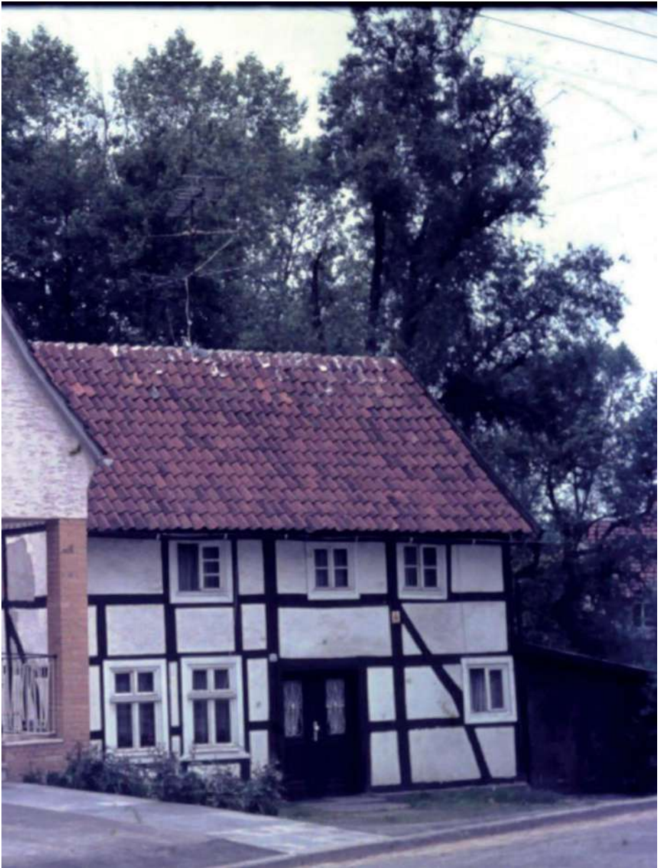
Das Fachwerkhaus der Familie Koch an der Aa wurde abgerissen.
