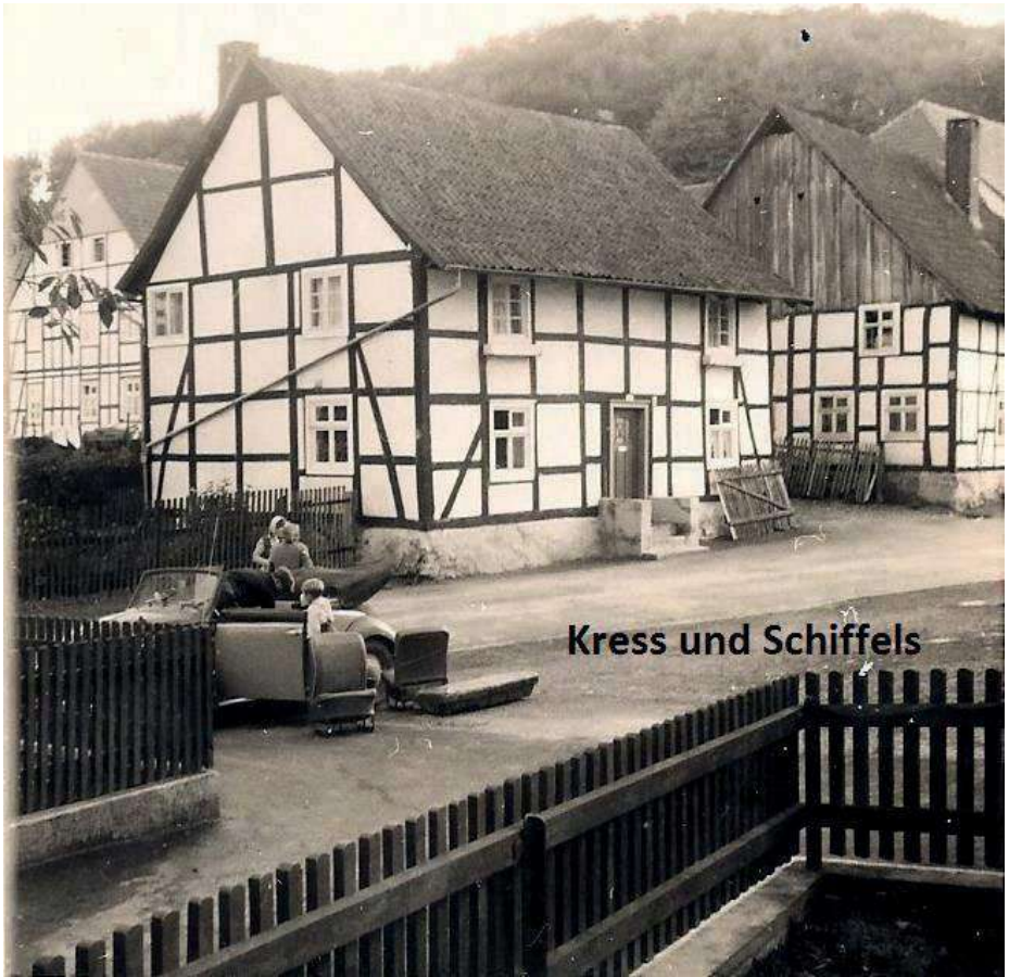
Beide Fachwerkhäuser wurden 1959 und 1961 abgerissen
