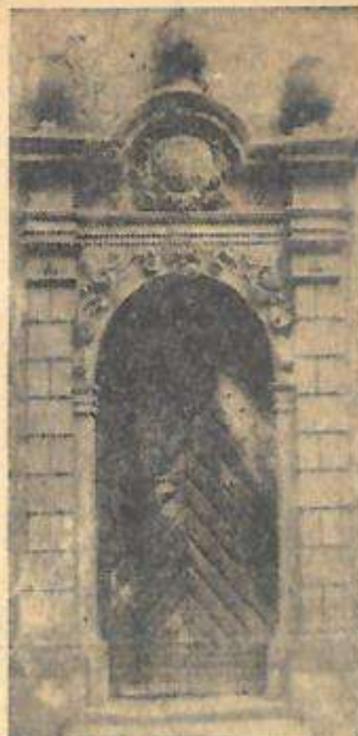
Dies ist der Haupteingang zur Pfarrkirche, die 1696/97 erbaut und dem hl. Bartholomäus geweiht wurde. Reich verziert und vom handwerklich-künstlerischen Sinn der Bauleute vor 250 Jahren kündend, steckt darin noch eindrucksvoll der Wille, in den Steinzeichen das Symbol des Eingangs zum geweihten Raum des Dorfes deutlich werden zu lassen.
